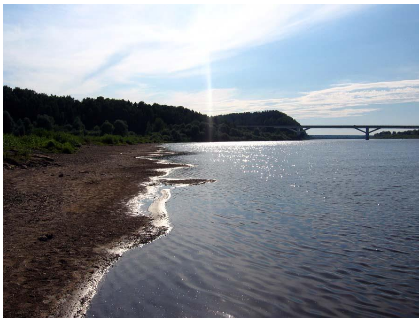
Фото 3.6-3. Мост через р. Вятку.
